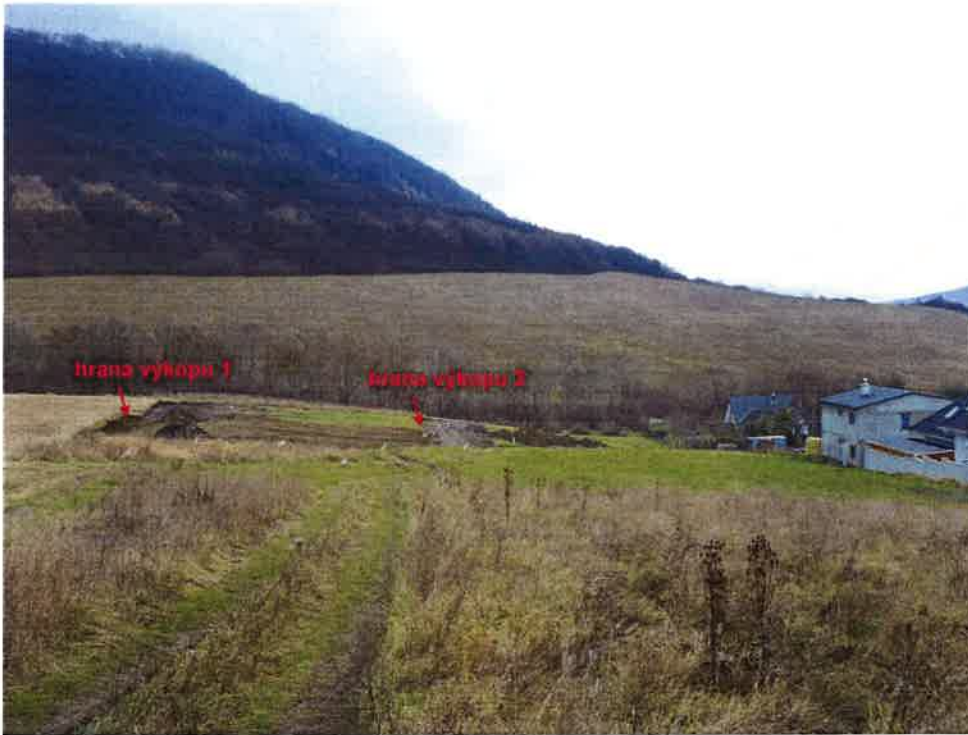
Obr. 3. Terénne úpravy v čele zosuvu (pohľad zo západu; parcely č.: 1204/56, 1204/57, 1204/58, 1204/59 – hrana výkopu 1, 1204/35 – hrana výkopu 2)
